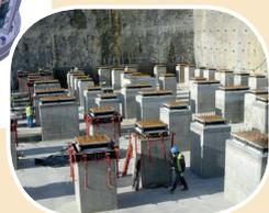
→ Aseismic pads
